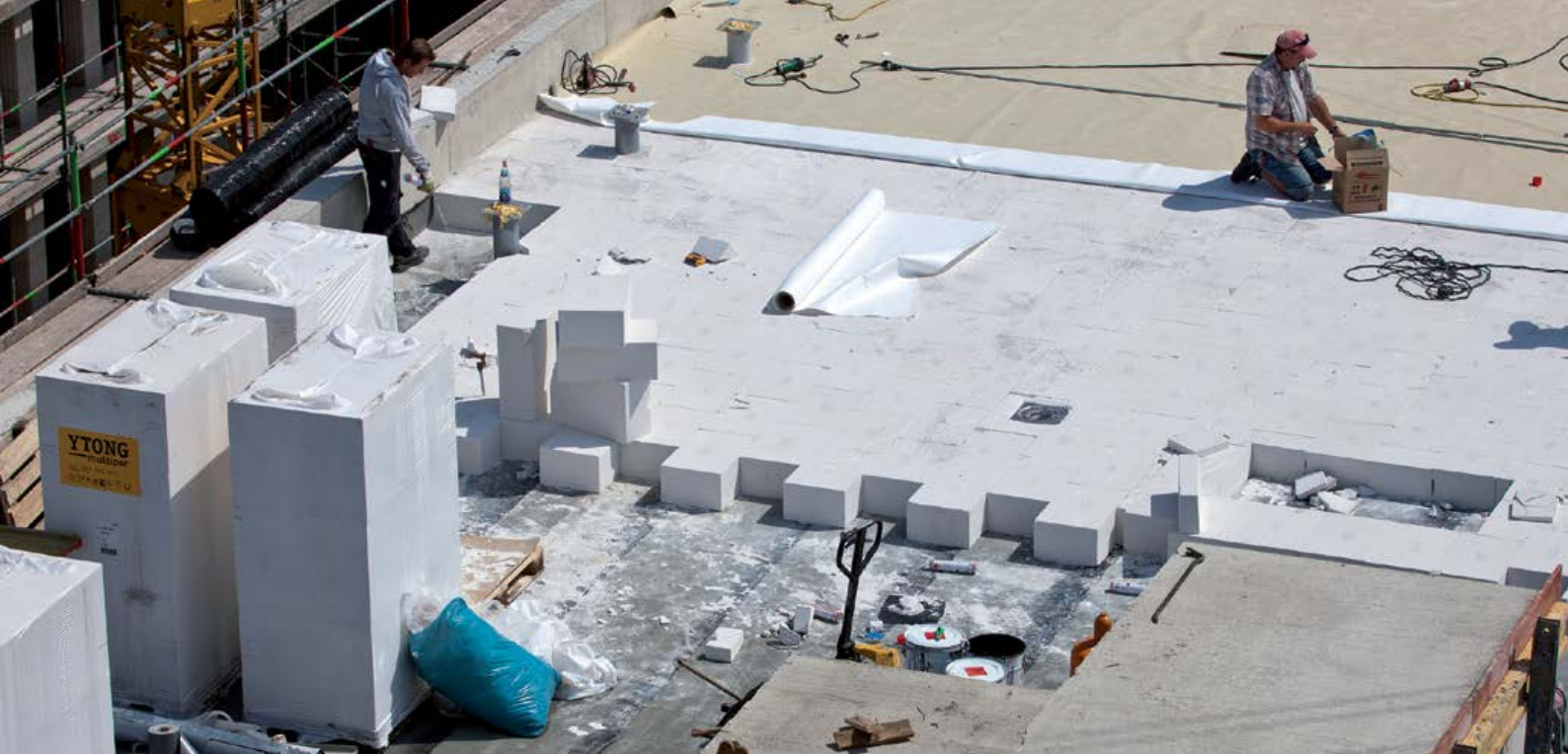
Izvedba izolacije ravne strehe z Multipor ploščami
