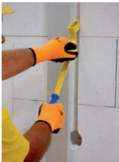
**58** Utore za elektro ali vodovodne instalacije izdelate z električnim rezkarjem ali Ytong strgalom. Aluminijasta letev vam služi kot vodilo. Površine zidu ni dovoljeno »štemati«.
