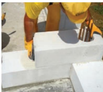
**18** V drugi vrsti s postavitvijo protipotresnega zidnega bloka notranjega nosilnega zidu že dobite preklop oz. zidarsko vezavo z zunanjim nosilnim zidom. Nato nadaljujte s postavitvijo blokov v tankoslojno lepilno malto v vseh smereh.
