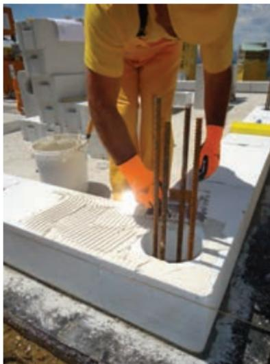
**13** Za zidanje z Ytong elementi uporabite izključno Ytong belo tankoslojno lepilno malto. Zaradi potresne stabilnosti objektov morate mazati horizontalne in vertikalne stične površine (spojnice). Površina mora biti čista in ravna.
