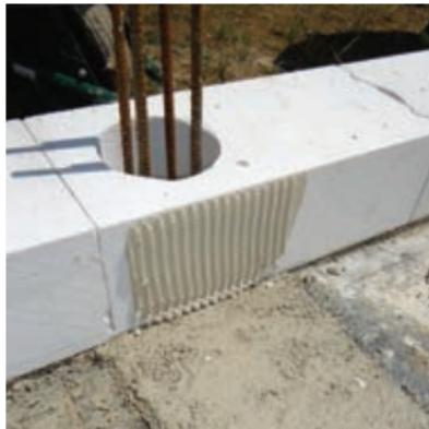
**16** Začetek postavitve vertikalne vezi oz. priključka notranjega in zunanjega nosilnega zidu prav tako izvedete v podaljšano malto na že pripravljeno hidroizolacijo. Površina podaljšane malte mora biti v obeh smereh zidanja popolnoma ravna, kar daje osnovo za nadaljevanje postavitve prve vrste.
