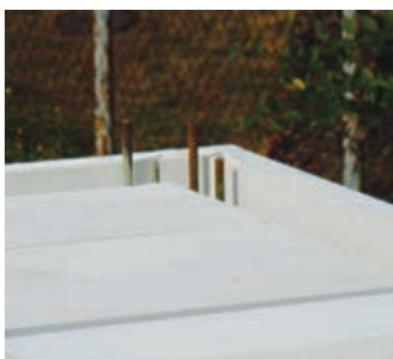
**44** Na notranjo stran zunanje stene Ytong L elementa morate dodati 3-4 cm dodatne toplo-tne izolacije (npr. Multipor), da preprečite nastanek toplotnega mostu.
