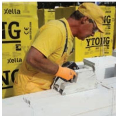
**27** Parapetni zid morate zaradi potresne varnosti armirati v drugi in tretji vrsti (od odprtine navzdol) z armaturo Ø 6 ali Ø 8 mm, odvisno od širine odprtine. Na vsako stran odprtine mora biti armatura podaljšana za 50 cm.
