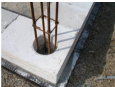
**23** Na vogalih, mestih stikanja notranjega in zunanjega nosilnega zidu, ter prostih koncih zidu izdelajte vertikalne protipotresne vezi. Za izdelavo uporabite protipotresne zidne bloke. Ko zgradite zid do želene etažne višine, vstavite v odprtino potrebno armaturo in jo zapolnite z betonom.
