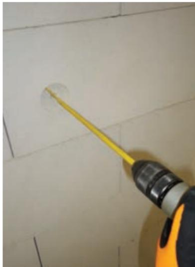
**59** Odprtine za električne elemente (npr. stikala, vtičnice, razvodne doze ...) preprosto izvrstate z nastavkom, ki je pritrjen na vratilni stroj, na isti način izvedete tudi preboje skozi zid. Po položitvi instalacij preostalo odprtino zapolnite s podaljšano apnenou cementno malto, končno finalizacijo pa izdelate s tankoslojnim notranjim ometom ali izravnalno maso.
