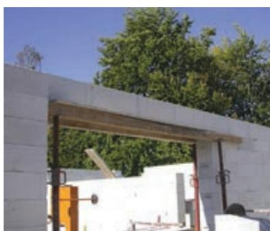
**34** Po položitvi armature in zlitju nosilca z betonom lahko nadaljujete z zidanjem. Izdelano konstrukcijo morate pustiti podprtto dokler beton ne doseže zadostne trdnosti.
