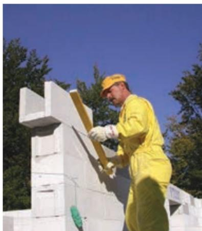
**31** Horizontalno vez ali nosilec izdelate z Ytong U elementi, ki vam služijo kot dvo- ali trostranski opaž. V te elemente vstavite armaturo in jih zalijete z betonom. Ytong U elemente polagate podobno kot Ytong bloke in jih bočno (s strani) medsebojno polepite.
