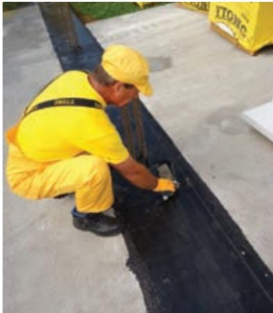
**01** Na izdelano tlorisno površino (temelji, ...), kjer ste pustili armaturo sidrne dolžine, začrtajte potek zunanjih in notranjih nosilnih zidov. Pred pričetkom zidanja oz. postavitve prve vrste, izdelajte hidroizolacijo in preverite ravnost površine.
