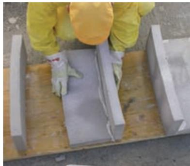
**41** Izrezane dele U elementa medsebojno polepite in s tem dobite opaž nepravilne oblike kot zaključek izdelanega zidu za izdelavo horizontalne vezi ali nosilca.
