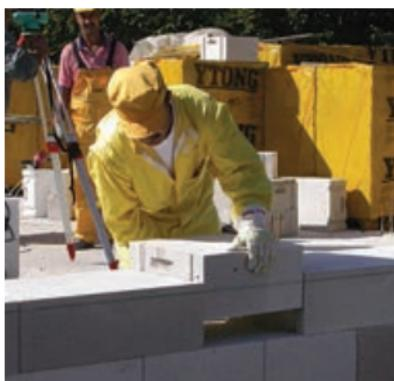
**22** Zapolnitev zidu dosežete z vmesnim elementom, ki ga enostavno in hitro izrežete z Ytong orodjem (ročno, električno ali tračno žago). Vsekakor morate predhodno namazati horizontalno in vertikalno spojno površino.
