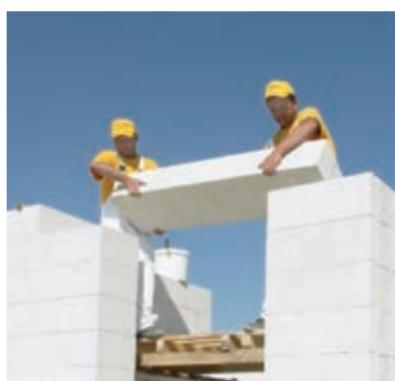
**36** Preklado položite na nosilni zid, nad okensko ali vratno odprtino, na pripravljeno ležišče, dolžine 15–20 cm. Širina preklade je prilagojena širini zidu, to je debelini od 20–30 cm in višine 25 cm.
