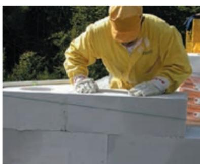
**21** S horizontalno kontrolo dosegete ravnost v vzdolžni smeri zidu. Morebitne nepravilnosti morate sproti odpravljati. Vsaka nepopravljena napaka lahko povzroči neravno površino, zmanjšanje izolativnosti materiala ter oslabitev v konstrukciji.
