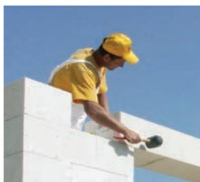
**38** Po položitvi druge preklade kontrolirajte horizontalnost v prečni in vzdolžni smeri. V primeru odstopanj ponovno poravnajte ležišče. Z zidanjem lahko nadaljujete takoj po vgradnji preklad.
