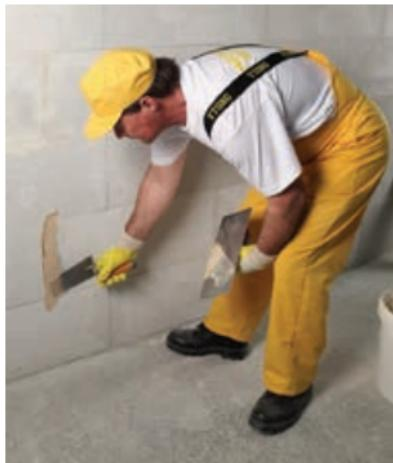
**64** Vse morebitne večje udrtine, nepravilnosti ter utore nastale tekom zidanja in vgradnje inštalacij, morate predhodno zapolniti z apneno cementno malto.
