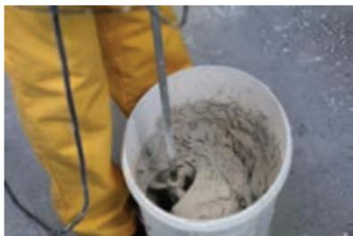
**67** Suho mešanico Ytong ometa počasi dodajte v vedro z vodo in premešajte z električnim mešalnikom 2 min. Počakajte 5 min in ponovno dobro premešajte. Za pripravo ometa iz 25 kg vreče potrebujete 9-10 l vode.
