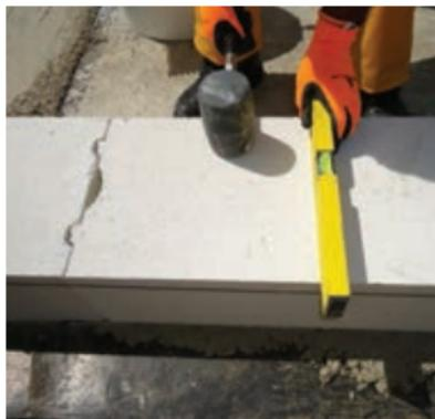
**04** Prvo vrsto nad osnovno površino (temelj, plošča ...) postavljate v podaljšano malto 1:2:8 (cement : apno : pesek) primerne konsistencije na že izdelano hidroizolacijo. Debelina podaljšane malte je odvisna od ravnosti površine in znaša cca. 1 do 2 cm.
