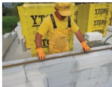
**30** V tako izdelan utor vstavite armaturo Ø 6 ali Ø 8 mm ter zalijete s cementno malto 1:3, izdelano z agregatom 0–4 mm. Po izdelani mikro vezi v drugi vrsti, izdelajte isto vez še v tretji vrsti. Vse naslednje vrste v zidu ne armirate.
