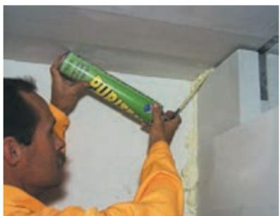
**57** Predelno steno prav tako dilatirate od stropne konstrukcije s horizontalno fugo debeline 2 cm in zapolnite s poliuretansko peno.
