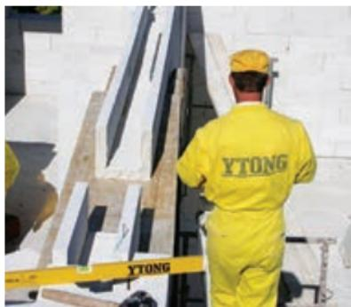
**32** Nosilec izdelate z Ytong U elementom tako, da najprej postavite spodnji opaž s podporno konstrukcijo, na katerega potem položite Ytong U elemente kot trostranski opaž.
