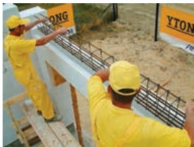
**33** V postavljenе Ytong U elemente vstavite armaturo in zlijete z betonom, izdelanim z agregatom frakcije 0-16 mm. Armaturo določi nadzorni organ po predhodno izdelani statični presoji.
