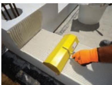
**14** Malto nanašajte na zid v dolžini 2–3 m. S tem dosežete maksimalno delovno učinkovitost. Zidajte pri temperaturah +5 °C do +25 °C. V primeru suhega in vročega ozračja priporočamo navlažitev Ytong gradbenih elementov.
