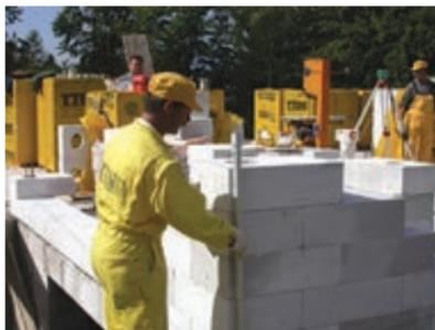
**20** Med zidanjem morate z libelo sproti, vrsto za vrsto, kontrolirati vertikalnost zidu. Kontrolirati morate v prečni in vzdolžni smeri zidu.
