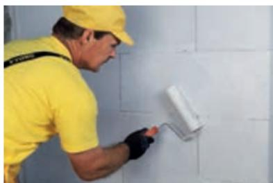
**65** Površino dobro očistite prahu. Skladno z navodil na površino z valjčkom ali čopičem nanesite prednamaz UNI.
