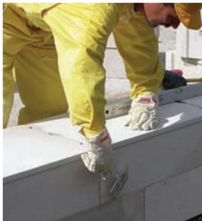
**24** Odvečno lepilno malto sproti odstranjujte s pozidanega zidu. Nezapolnjene stike ali večje odprtine ne zapolnjujte z lepilno malto, pač pa jih zapolnite z apneno cementno malto.
