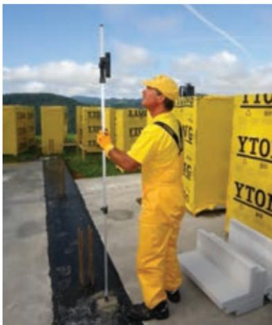
**02** Popolno ravnost površine doseglete tako, da na vogalih (in na vsaka 2 m razdalje) z nivelnjem določite višinske točke. S tem dobite osnovno koto  $\pm 0.00$  po celotni zazidalni površini.
