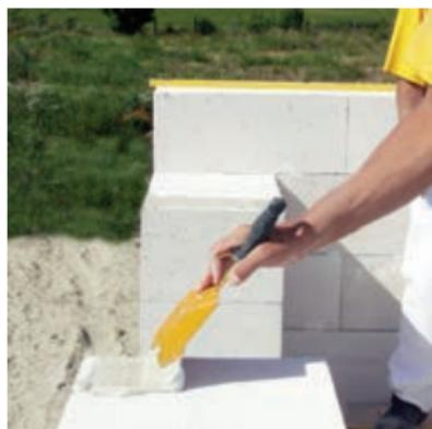
**35** Za premostitev odprtin uporabite izključno Ytong preklade in tako preprečite nastanek toplotnih mostov. Za njihovo vgradnjo ne potrebujete opaža in podpornih elementov. Mesto naleganja (ležišče), ki mora biti ravno in čisto, horizontalno in vertikalno premažite z Ytong tankoslojno lepilno malto.
