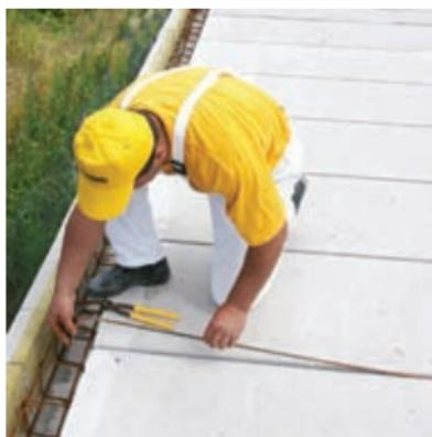
**52** Polagate jih direktno na konstrukcijo ali horizontalno vez v ležišče z minimalnim 8 cm naleganjem. Plošče imajo na zgornji strani utor, v katerega položite armaturo  $\geq \varnothing 8$  mm, ki jo nato povežete z armaturo iz horizontalne vezi in zalijete z betonom.
