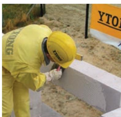
**37** V primeru širšega zidu, kot je preklada, montirate dve prekladi, da dobite isto širino, kot je širina zidu. Stično površino med prekladama morate premazati z Ytong tankoslojno lepilno malto.
