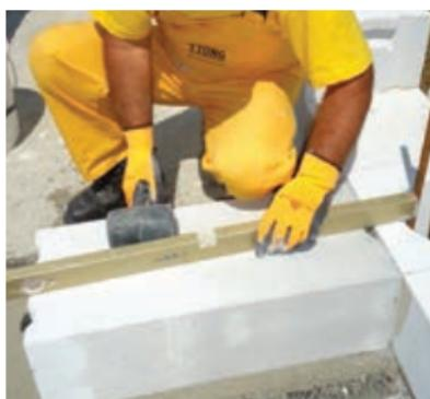
**17** Na mestu izdelave vertikalne vezi postavite najprej protipotresni zidni blok zunanjega nosilnega zidu in ga na zunanji strani poravnajte z vogalnimi protipotresnimi bloki. Nato nadaljujte s postavitvijo zidnega bloka notranjega nosilnega zidu in preverite horizontalnost v obeh smereh.
