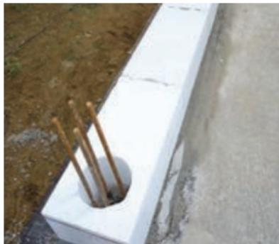
**05** Prvo vrsto Ytong blokov začnete vedno postavljati na vogalih objekta. Ytong protipotresni zidni blok postavite na mesto, kjer je puščena iz temelja predpisana vertikalna armatura. Preverite horizontalnost v prečni in vzdolžni smeri poteka zidu.
