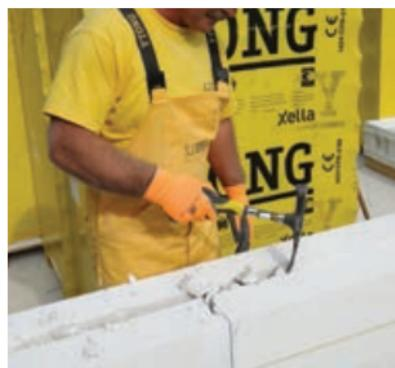
**28** V Ytong blok zarežete po sredini z električnim rezkarjem ali diamantnim rezilom dva reza, globine 5 cm, v medsebojni oddaljenosti 5 cm. Z zidarskim kladivom ali Ytong strgalom nato izdolbete utor.
