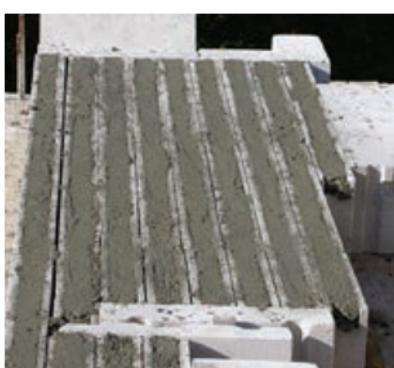
63 Ko beton doseže minimalno tlačno trdnost (3 dni), element obrnete (betonski presek je spodaj) in ga položite v že izdelano ležišče, ki mora biti dolžine 15 do 20 cm na vsako stran odprtine. Na ta način lahko izdelate razne montažne elemente (npr. pokrovne za zapiranje roletnih omaric).
