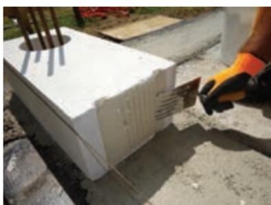
**15** Pri nosilnih zidovih na vertikalni stični površini namažite oba utora in celo površino med njima. S tako premazano površino dosežemo maksimalno stikanje blokov vertikalnih spojnic in minimalno debelino vertikalnega stika, to je 2-3 mm. Zidove morate v primeru obilnih padavin zaščititi s folijo.
