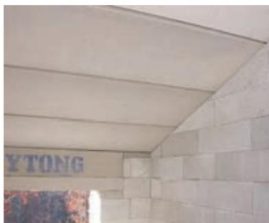
**53** Po zalitju z betonom dobite monolitno konstrukcijo z dodatno toplotno izolacijo. Za izdelavo ravne površine stike med ploščami bandažirate z mrežico in nanesete notranji tankoslojni omet ali izravnalno maso po celi površini plošč.
