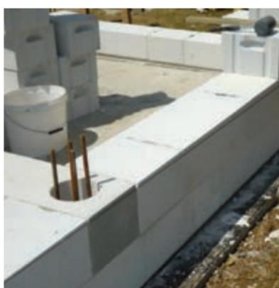
**19** Pri izdelavi vertikalne vezi morate paziti na uporabo pravega protipotresnega zidnega bloka notranjega nosilnega zidu zaradi pravega odmika odprtine od zunanjega roba zidu. Na vseh omenjenih mestih morate izdelati zidarsko vezavo in uporabiti protipotresne zidne bloke.
