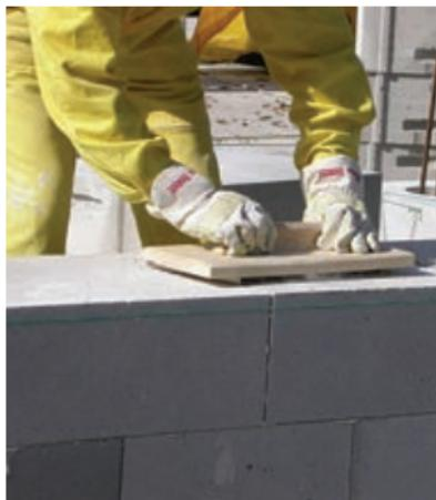
**25** V postopku zidanja lahko na površini (horizontalni spojnici) nastanejo neravnine oz. povišanja bloka do bloka. Takšne neravnine morate odstraniti (odbrusiti) z Ytong desko za izravnavo.
