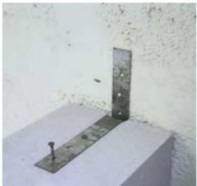
**54** Predelne stene izdelate z Ytong zidnimi ploščami debeline 10, 12,5 ali 15 cm. Vsako tretjo vrsto morate po višini sidrati v nosilni zid z Ytong elastičnim sidrom, pritrjenim v zid s pocinkanimi žebli.
