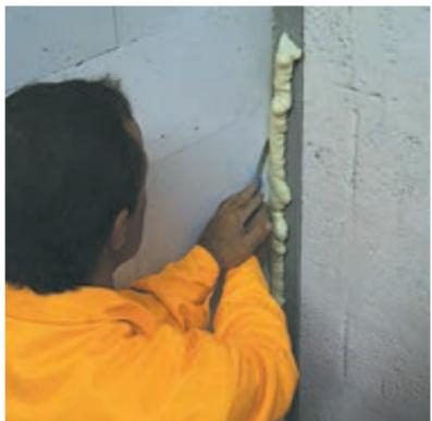
**56** Predelno steno na mestu stikanja z nosilno steno dilatirate po vertikali z vertikalno fugo debeline 1 cm, ki jo po zaključku zidanja zapolnite s poliuretansko peno.
