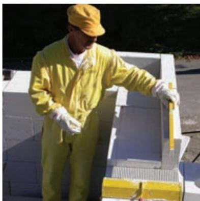
**43** Zunanjo horizontalno vez ali zaključek stropne konstrukcije izdelate z Ytong L elementi brez uporabe dodatnega opaža.
