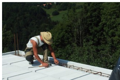
Vstavljanje armatur v prečna nosilna rebra pri izvedbi Ytong stropa.
