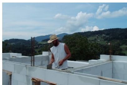
Izvedba dvostranskega opaža in toplotne izolacije horizontalne vezi z U elementi.
